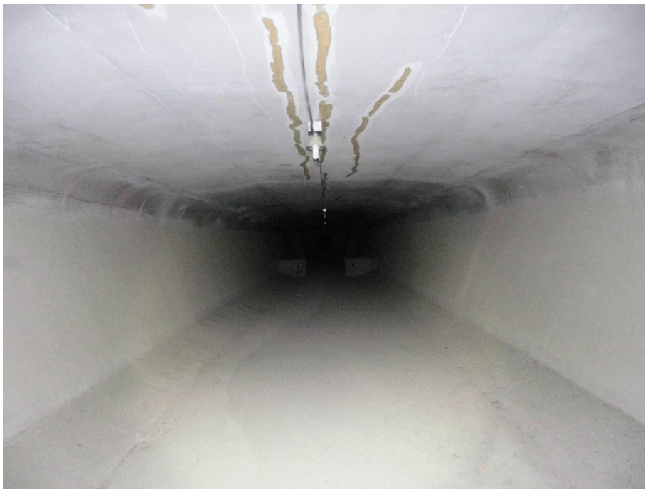
PSC BOX 내부 전경
