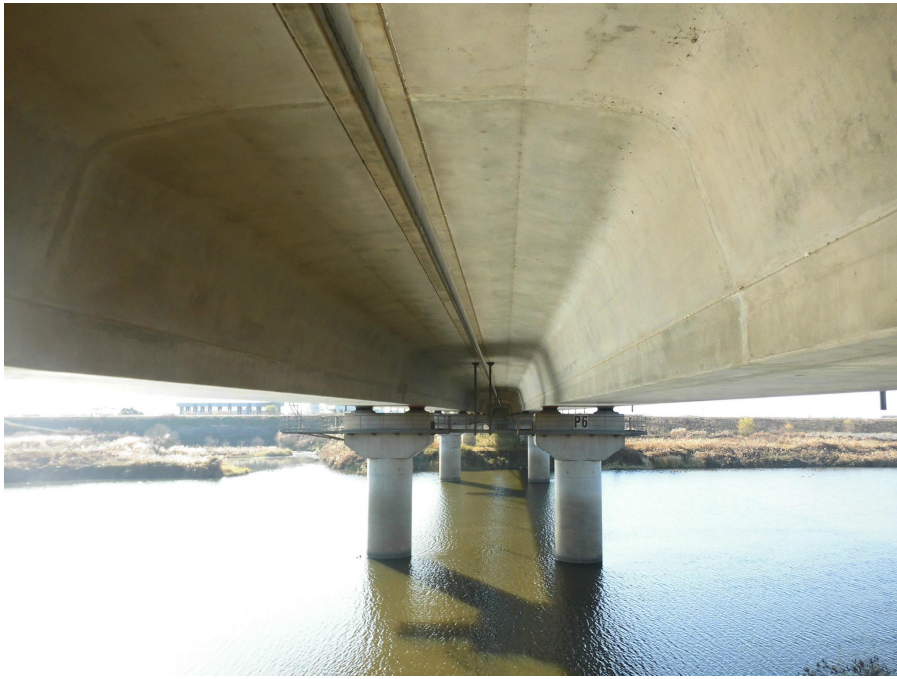
바닥판하면 및 거더 외부 전경
